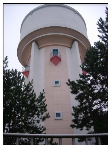
Réservoir de Saint-Ouen-l'Aumône rue du Parc 1000 m 3
