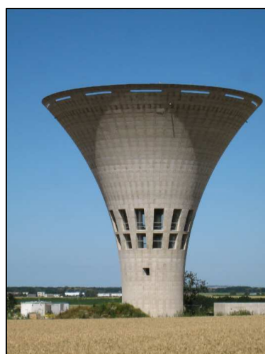
Réservoir de l'Oseraie Osny (2 x 2500m 3 )
