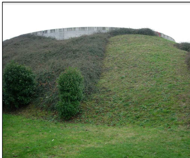
Réservoir du Bois d'Aton à Courdimanche 2500 m 3
