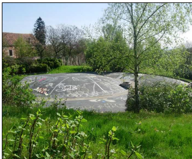
Réservoir de Boisemont 2 x 4000 m 3
