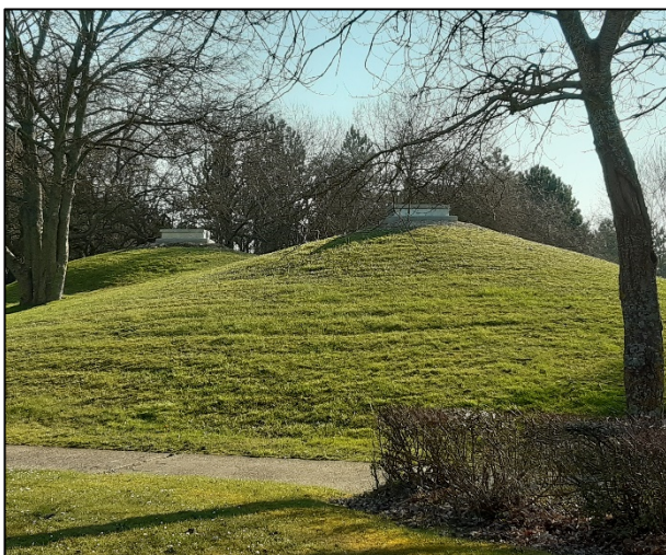
Réservoir de Cergy les Clos Billes
