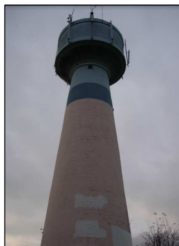
Réservoir de Courdimanche 250m 3
