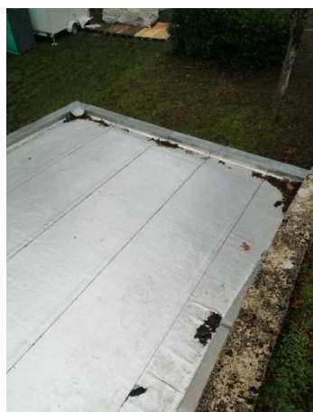
Etanchéité toit terrasse local vanne cuve n°1 Boisemont 2x4000m3
