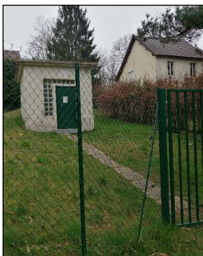
Réservoir Relais de Boisemont 120 m 3
