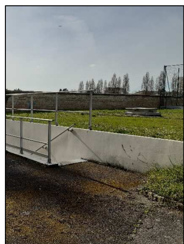
Réservoir de Pontoise rue Claude Debussy 1500 m 3
