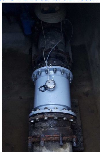
Réservoir de Marcouville (distribution Osny), renouvellement du débitmètre DN400
